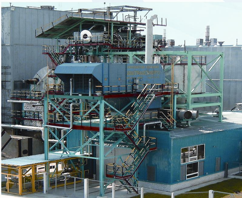
Когенерационный блок 15 МВт + КУП-70 (70 т/ч пара) + 6 МВт (паровая турбина), «Рубежанский картонно-тарный комбинат», г. Рубежное, Украина
