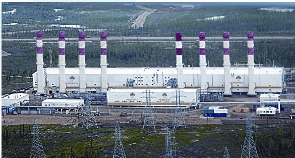
8 КУВ-33 за 8 ГТУ General Electric MS-5001 (26 МВт), ГТЭС 200 МВт, Ванкорское месторождение, Красноярский край, РФ
