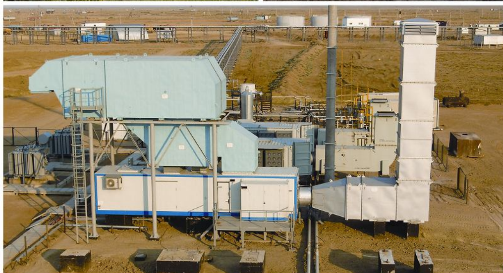
ЭГ2500-М1 – газотурбинная электростанция мощностью 2500 кВт
